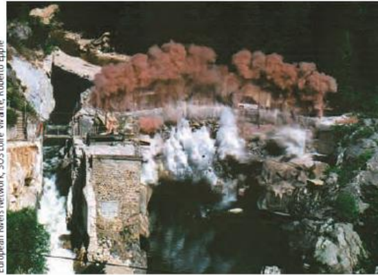
La démolition du barrage de Saint-Étienne-du-Vigan à la dynamite en juin 1998. Le cours d'eau est détourné en rive droite.
