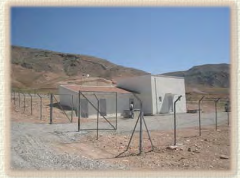
800 ve 500 m 3 'lük su deposu
