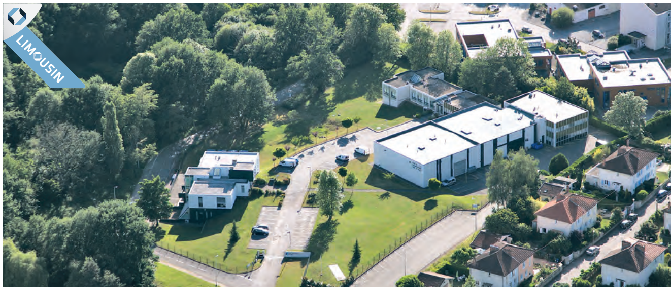
Nos installations à Limoges
