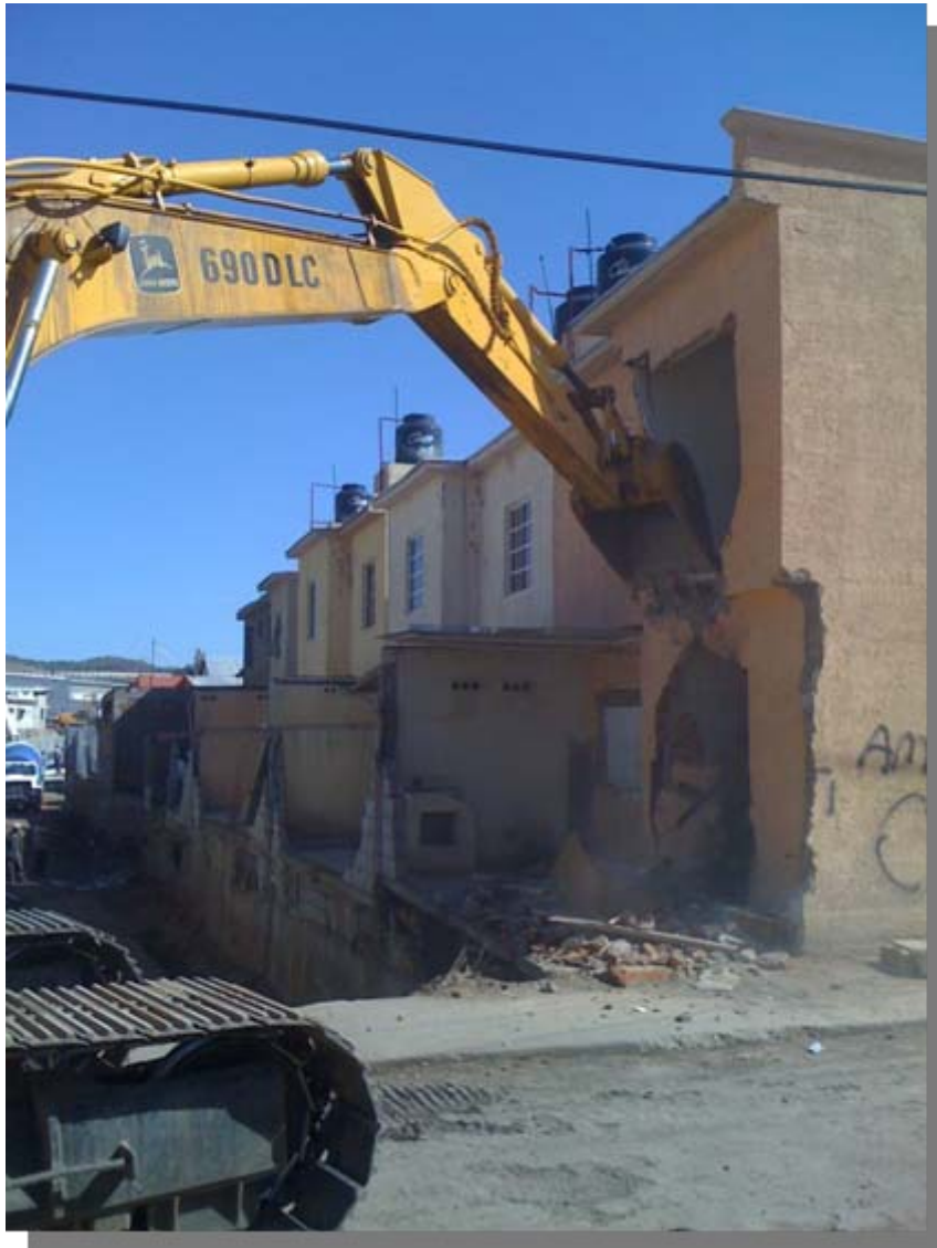
Demolición de construcción en cauce y zona federal
