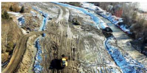
Travaux sur Drac en amont de Saint-Bonnet-en-Champsaur (photo © Charles Queyras TP)
