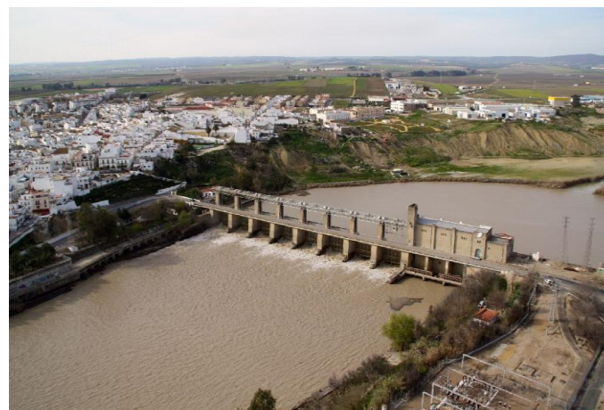
Alcalá del Río. Run-of-the-river power station
