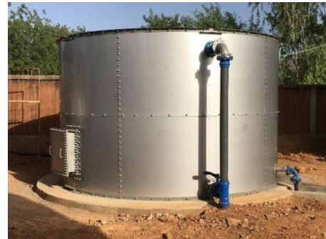
Instalación de un tanque de agua cruda
