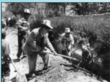
Travaux collectifs au village de Kunelek, Kirghizistan
